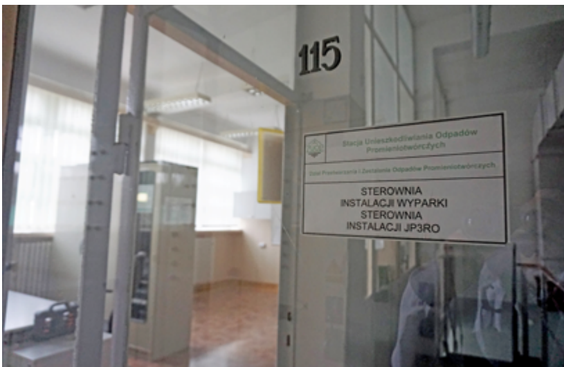
Fot. 3. Wejście do sterowni instalacji wyparnej
